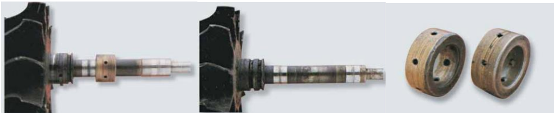
Eixos e mancais radiais arranhados devido à presença de óleo lubrificante contaminado.
